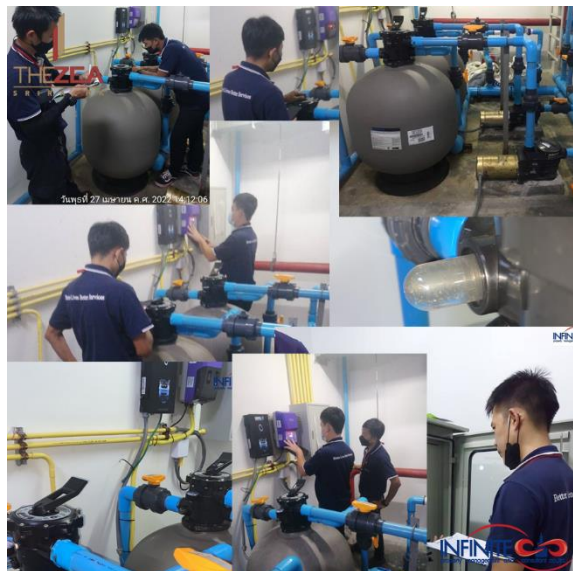
ภาคผนวกที่ 3.53 ตรวจสอบระบบกรองน้ำ และผลิตคลอรีนของสระว่ายน้ำ
