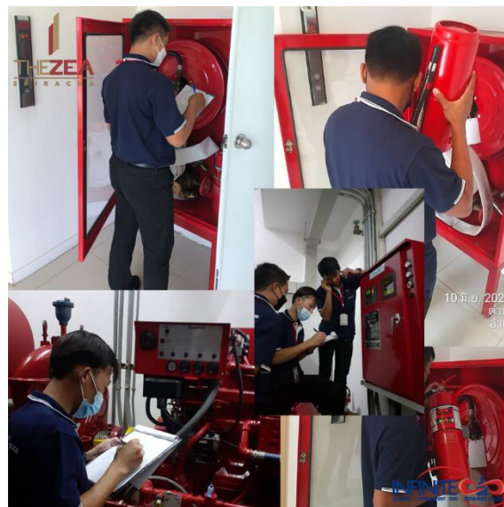
ภาคผนวกที่ 3.27 ตรวจสอบตู้แลอูปรณ์ป้องกันและเตือนภัยอัคคีภัย
